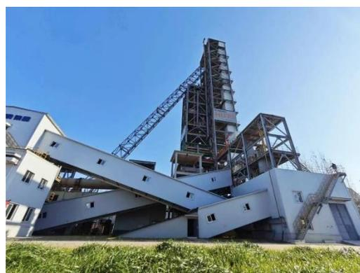
“氢冶金”项目改变传统钢铁生产工艺路线，采用“绿电制氢-绿氢还原”短氢流程工艺，以绿氢替代传统焦炭还原铁矿粉，实现了从“碳冶金”到“氢冶金”的转变，生产过程中碳排放降低90%以上。其中，制氢工段采用李灿团队研发的高效碱水电解技术，还原工段依托中国科学院过程工程研究所朱庆山研究员团队开发的流化床直接还原铁新技术。
